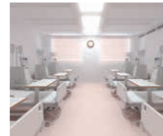
天井放射冷暖房システム
