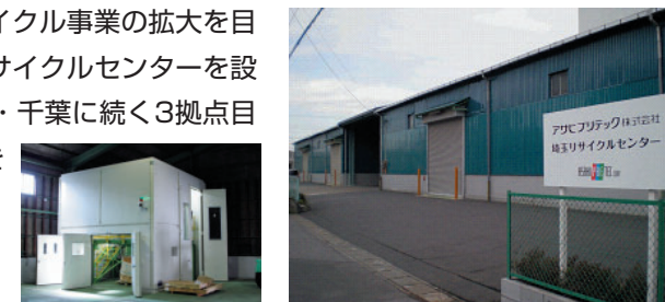
廃プラスチック等破砕施設
