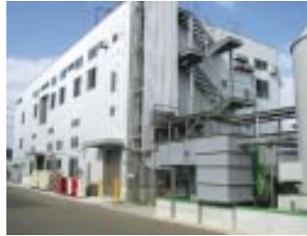
福岡工場（福岡県古賀市）
